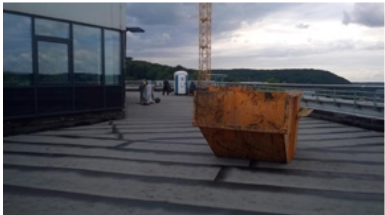
Terrassenarbeiten am Gebäude ME © mw
